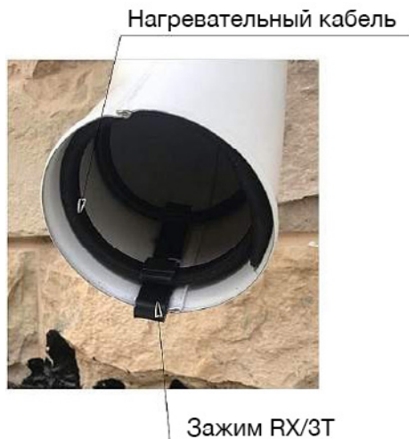
Рис. 4 (Крепление нагревательного кабеля с использованием зажима RX/3T, сливное колено)
