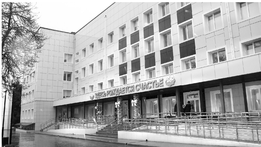
▲ В здании заменили инженерные сети, систему вентиляции, кровлю, лифты
