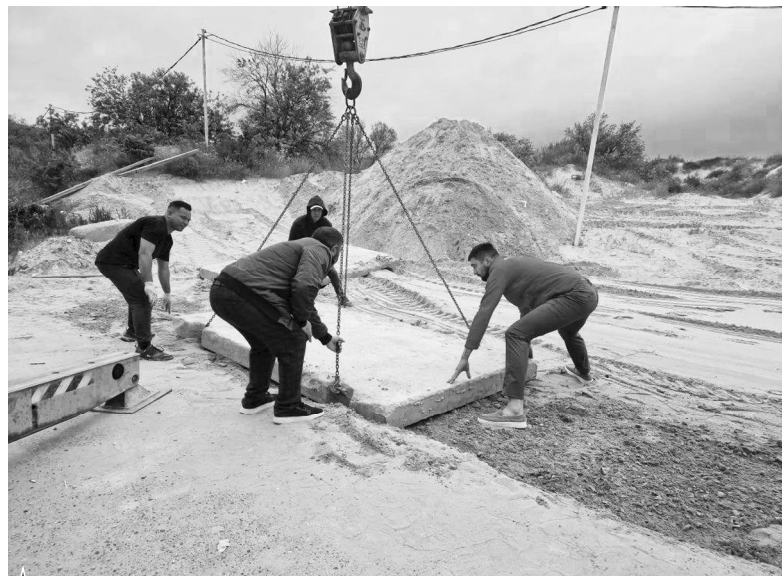
▲ Обустраивается очередной технологический проезд
