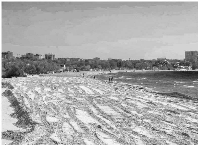
▲ Проведены работы по выравниванию нового слоя песка
