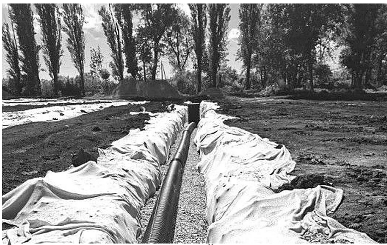
▲ Идет прокладка коммуникаций
