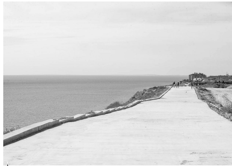
▲ Монолитные работы практически завершены
