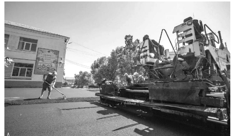
Завершается асфальтирование прилегающей территории
