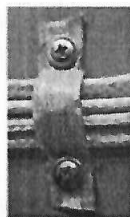
Рисунок 13 - Монтаж ОКЛ с помощью дюбель-хомута КФСТ.735322.041. Вариант 2.
