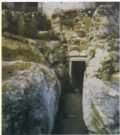
Вход в «Туннель Армон Анация» комплекса водовода. Глубина до 43 м, длина около 360м, ширина 1 м.
