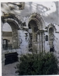
Фасад разрушенной синагоги «Тиферет-Израэль»
