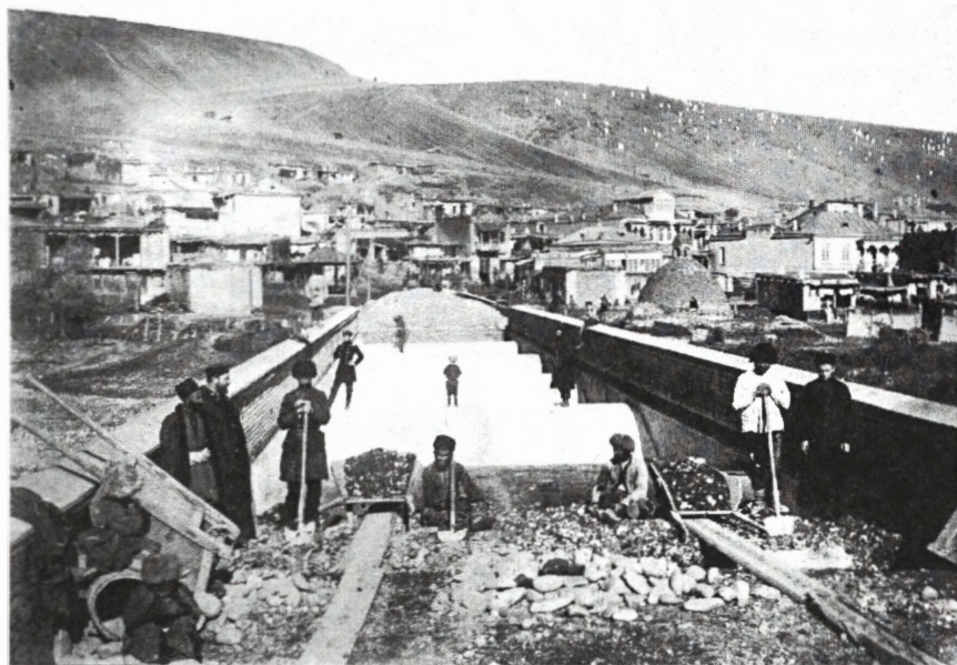
Строительство Старого моста (Красного) через Кудиял-чай, в Еврейской Слободе. Памятник архитектуры середины 19-20 века
