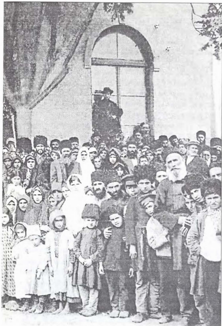
молитвенного дома — синагоги), построенного Вид с улицы. Около 1909 года
