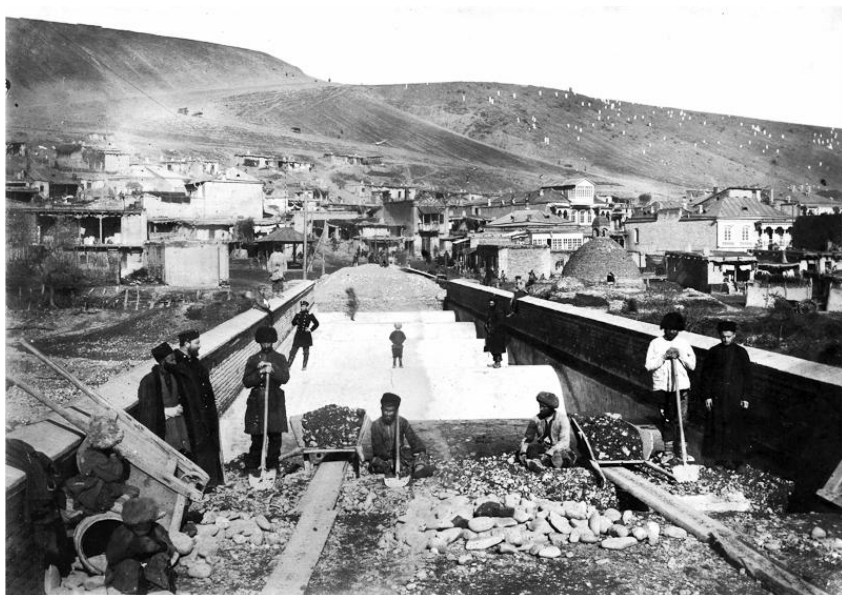
Строительство Старого моста (Красного) через Кудиял-чай, к Еврейской Слободы. Памятник архитектуры середины 19-20 века
