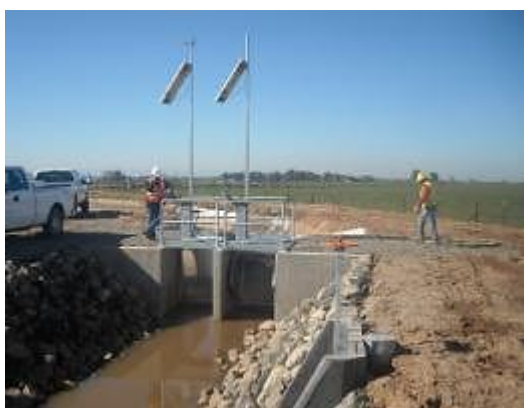
Рис. 3. Ворота шлюзов до и после модернизации системы орошения и внедрения АСУ.
