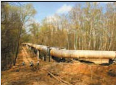
Прокладка теплопровода
