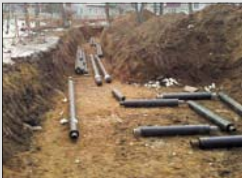
Строительство теплотрассы
