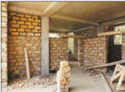
Места незавершённых строительных работ
