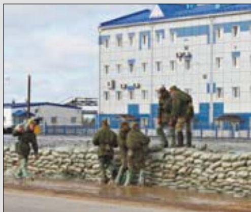
Возведение защитной дамбы из мешков с песком при угрозе наводнения
