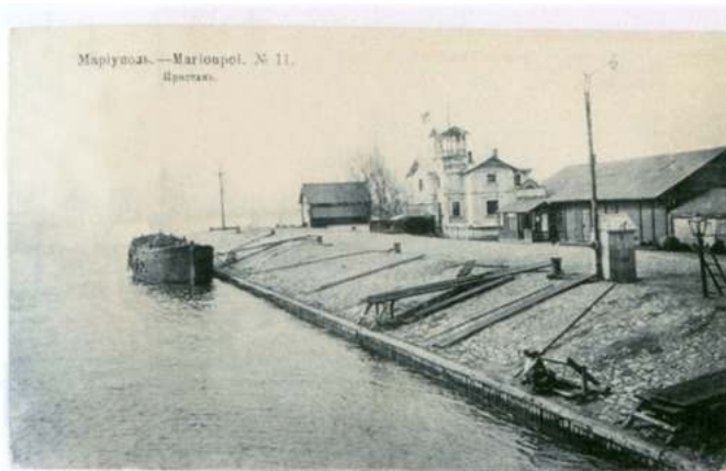
Пристань. На снимке здание «Мариупольского общества спасения на водах»
